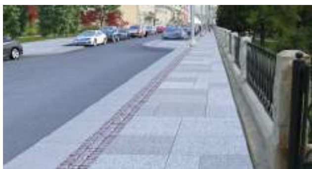
Илл. 1.1.8. ПРИМЕРЫ МОЩЕНИЯ ОБЩЕСТВЕННЫХ ПРОСТРАНСТВ ПЛИТКОЙ ИЗ НАТУРАЛЬНОГО КАМНЯ
